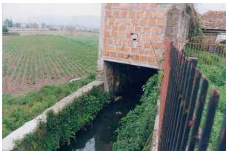
Figura 191. Lagno di Arpaia (Bacino del Carmignano). Vista verso valle del tratto situato in prossimità del centro abitato di San felice a Canello (Fonte AdBNO – 2001).
