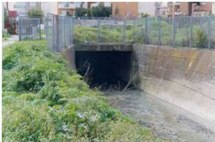
Figura 173. Lagno di Spirito Santo. Vista verso monte dello sbocco del tratto tombato che attraversa il centro abitato di Pomigliano d'Arco (Fonte AdBNO – 2001).
