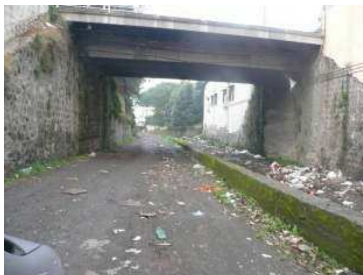
Figura 169. Vista verso monte del Lagno di Leone. Tratto in corrispondenza del ponte di via Aldo Moro.
