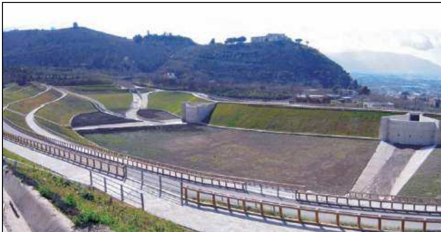
Figura 81. Vasca di Episcopo presso Sarno. Esempio di piazza di deposito a più ingressi e due uscite (fonte: Quaderni del Presidio Territoriale – Commissario di Governo per l’Emergenza Idrogeologica in Campania).
