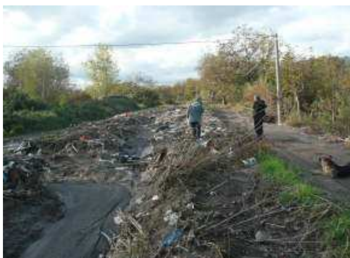
Figura 147. Lagno di Gaudio. Vista verso valle. Il luogo si trova a circa 600 m a valle del ponte della frazione di San Donato. Come si può notare da tale punto verso valle la sezione è completamente ostruita da
