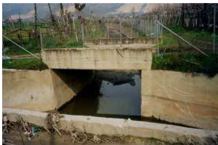
Figura 159. Lagno di Avella. Visto verso monte dell'imbocco del canale scolmatore. La foto è stata ripresa nel 2001 e mostra la sua sezione completamente pulita; attualmente il canale si presenta completamente interrato (Fonte AdBNO – 2001).
