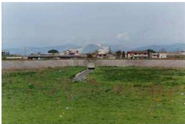
Figura 174. Lagno di Spirito Santo. Vista verso valle della vasca Guadagno, situata a sud del centro abitato di Pomigliano d'Arco. Nel centro della figura è visibile il manufatto di regolazione delle portate. (Fonte AdBNO – 2001).
