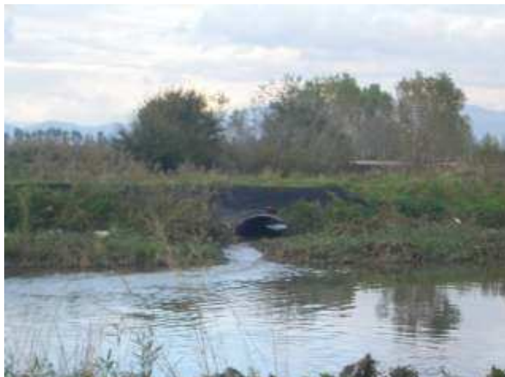
Figura 112. Canale dei Regi Lagni, il rivestimento in calcestruzzo è stato asportato ed è visibile la guaina impermeabilizzata (confluenza con il fiumarella).
