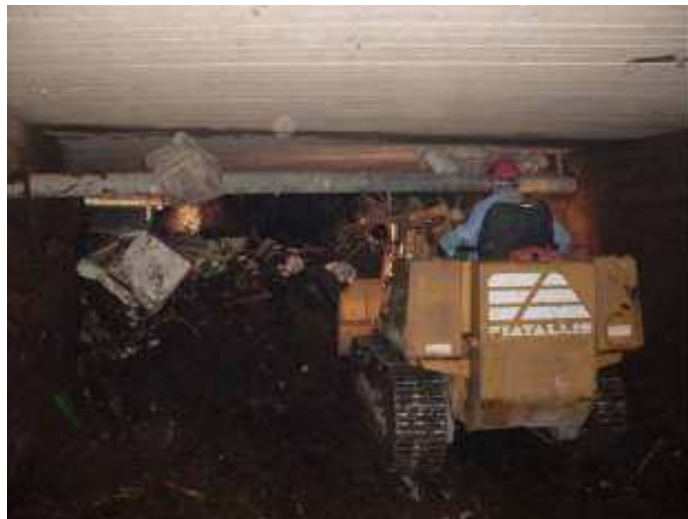
Figura 128. Lagno di Quindici. Vista dell'interno del tratto tombinato presente nel centro dell'abitato di Nola. La figura mostra le fasi di pulizia dal materiale depositato, eseguite nel 2008. Da notare la presenza del tubo della fognatura. (Gentile concessione del Dott. Del Gaudio – 2008)
