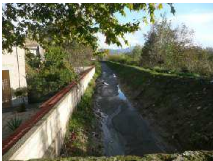
Figura 146. Lagno di Gaudio. Vista verso monte dal ponte della frazione di San Donato. Come nella foto vista precedentemente la sezione si mantiene regolare.
