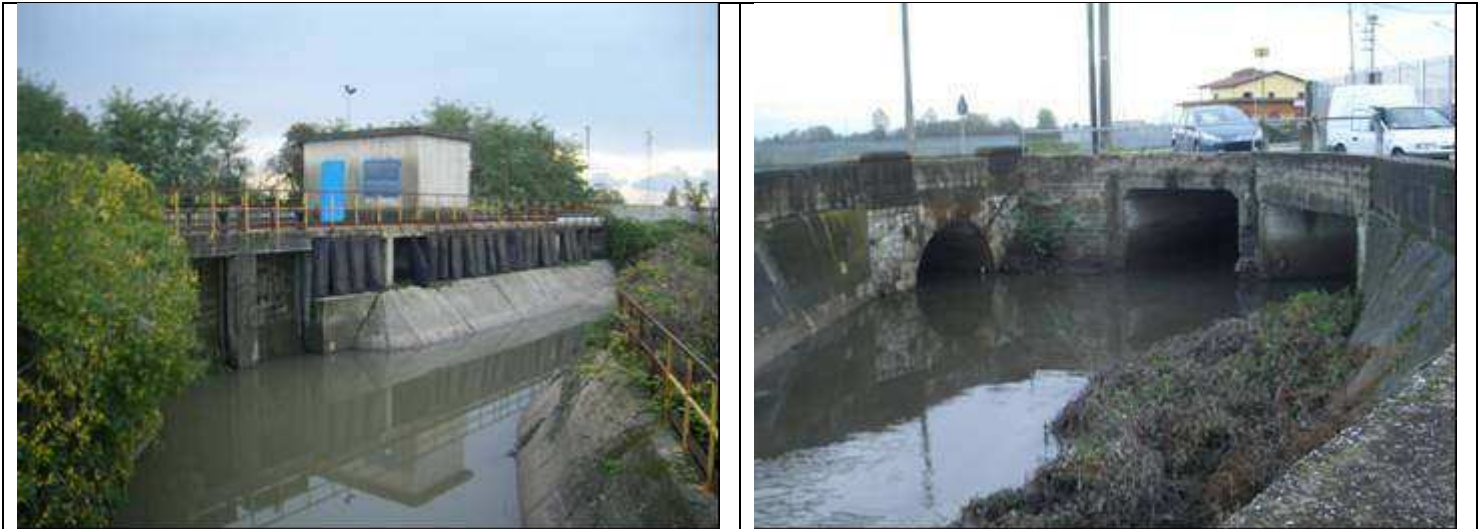
Figura 98. Fugatore Villa Literno: a sinistra il partitore a destra le immisioni dei tre collettori nel fugatore
