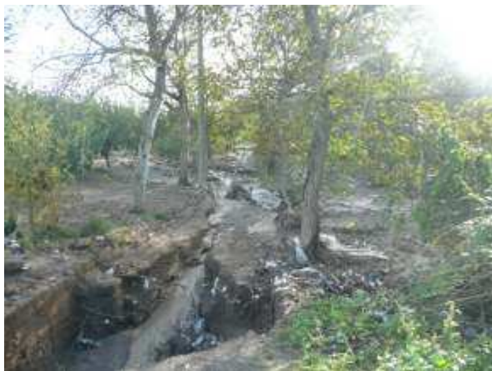
Figura 148. Lagno di Gaudio. Il corso d'acqua trovando la sezione ostruita, vista nella figura precedente, ha inciso un argine e si è riversato nella campagna laterale.
