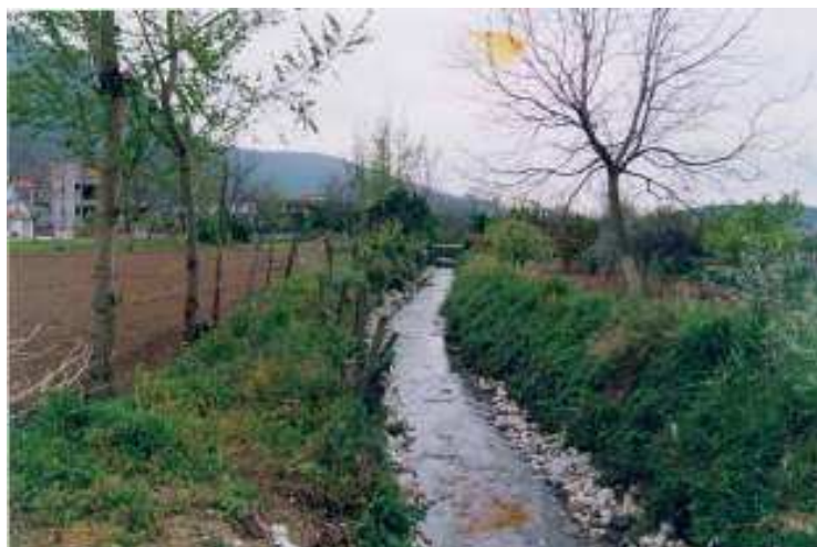
Figura 188. Lagno di Palata (Bacino del Carmignano). Vista verso monte del tratto situato in prossimità del centro abitato di San Marco (Fonte AdBNO – 2001).
