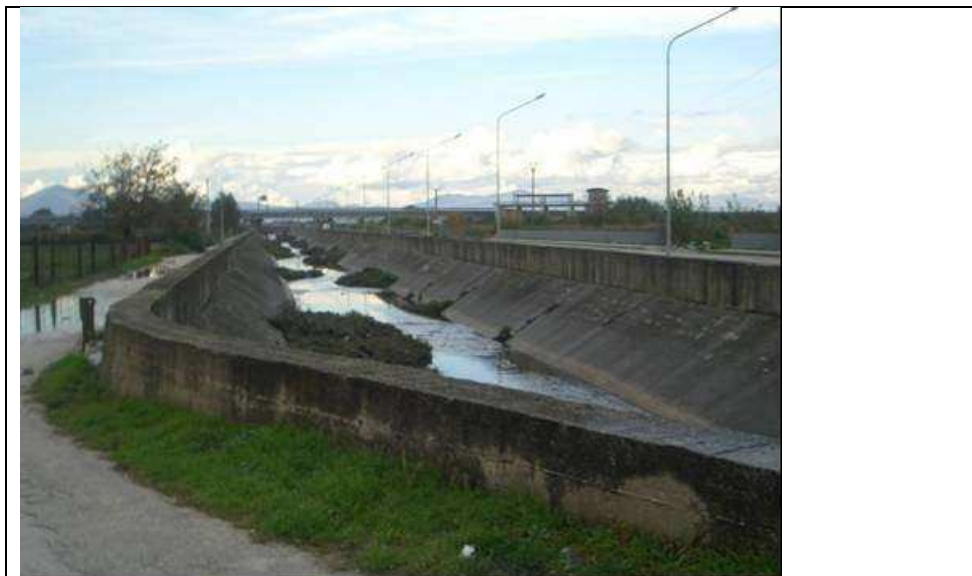
Figura 99. Fugatore Villa Literno dal partitore verso valle (si notano i due muri rialzati sugli argini)
