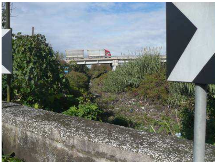
Figura 136. Lagno di Quindici. Vista verso valle in prossimità della confluenza con il Lagno di Casamarciano.
