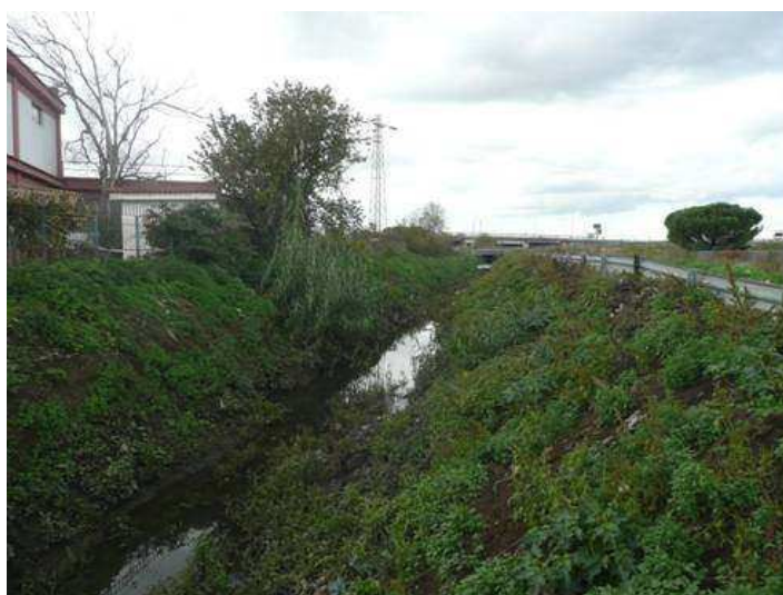
Figura 137. Lagno di Quindici. Vista verso valle in prossimità della zona commerciale di Nola.
