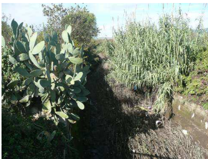
Figura 131. Lagno di Quindici. Vista verso valle del tratto in corrispondenza della confluenza del Lagno di Santa Teresa.
