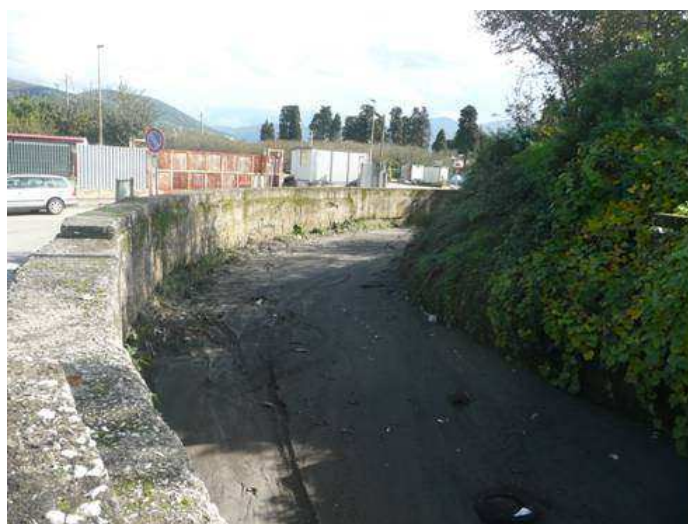
Figura 122. Lagno di Quindici. Vista verso monte. Curva in corrispondenza del cimitero di Nola. Come si può notare è presente materiale solido depositato.
