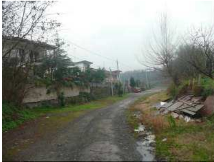
Figura 185. Lagno di Santa Maria. Vista verso monte del tratto a monte del centro abitato di Somma. Sono visibili degli accessi pedonali e carrai.
