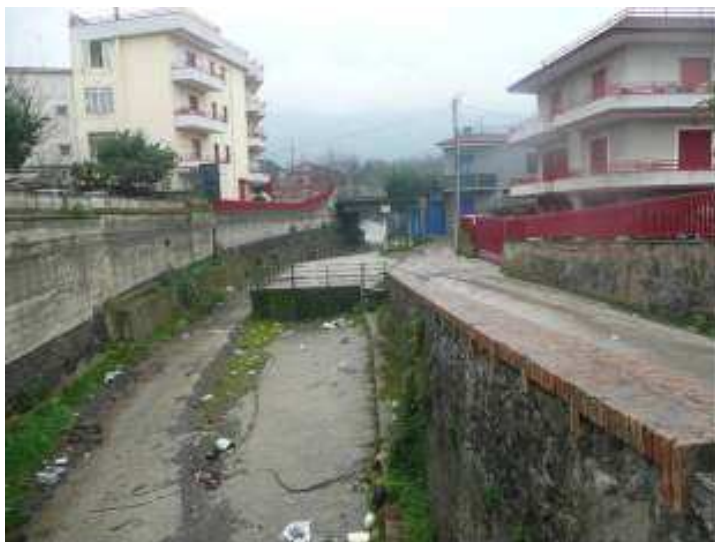
Figura 182. Lago di Amendolare. Vista verso monte in prossimità del ponte di Via Circumvallazione, visibile in secondo piano. È visibile la realizzazione di un sottopasso all'interno dell'alveo del lago.
