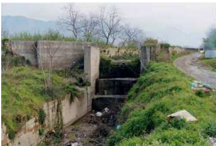
Figura 144. Lagno di Gaudo. Visto verso monte del manufatto in cemento per la regolazione del collegamento Avella - Gaudo (Fonte AdBNO – 2001).
