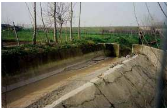
Figura 158. Lagno di Avella. Visto verso valle del manufatto modulatore. La foto è stata ripresa nel 2001 (Fonte AdBNO – 2001).
