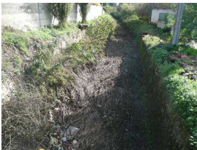
Figura 132. Lagno di Quindici. Vista verso valle del lagno nel tratto a ovest dell'abitato di Nola.
