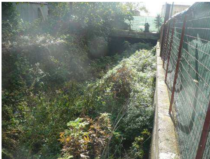
Figura 130. Lagno di Santa Teresa. Vista verso monte. Il Santa Teresa è un affluente minore del Lagno di Quindici, in questa foto è visibile l'uscita dal tratto tombinato che attraversa la zona sud di Nola.
