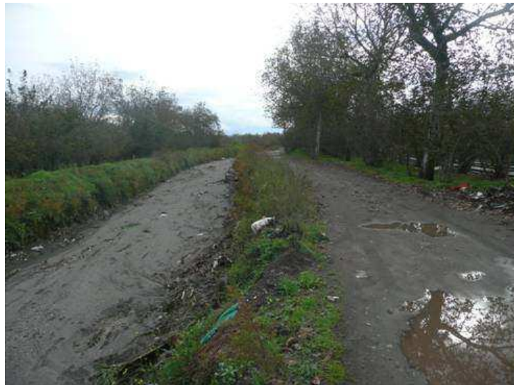
Figura 120. Lagno di Quindici. Vista verso monte. Tratto a sud del cimitero di Nola. La sezione si presenta arginata ed è presente materiale solido sul fondo. La quota attuale del fondo alveo è all'incirca la stessa del piano campagna.
