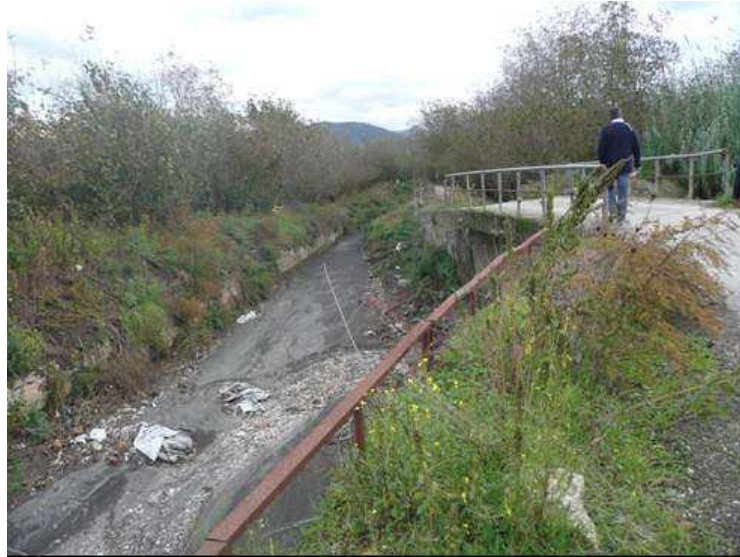
Figura 119. Lagno di Quindici. Vista verso monte della confluenza con l'Alveo Camaldoli, visibile al centro della foto, mentre il Lagno di Quindici proviene da sinistra. Confrontando con la foto precedente si può notare come il materiale solido trasportato sia in quantità maggiore proveniente dall'alveo di Camaldoli.
