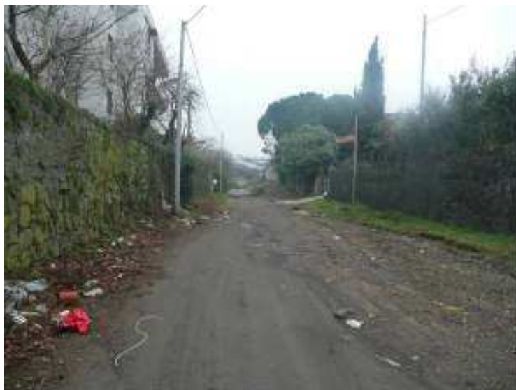
Figura 168. Vista verso monte del Lagno di Leone. Tratto a monte del ponte di Via Circumvallazione. Si può notare un accesso carraio sulla destra e la presenza dei pali dell'elettricità, tale tratto viene utilizzato per la viabilità locale.
