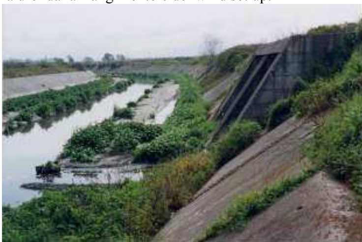
Figura 19. Canale principale dei Regi Lagni in corrispondenza della confluenza con il Lagno dello Spirito Santo (Sezione RL4). La foto è rappresentativa dello stato di sovralluvionamento e vegetazionale presente (Fonte AdBNO – 2001).
