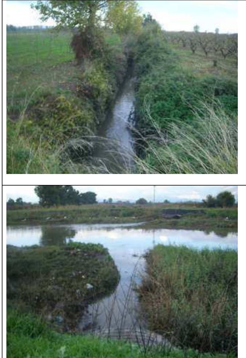
Figura 97. Fugatore Bonito: sopra vista del fugatore dall'argine dei regi lagni verso monte , sotto l'immissione nei Regi Lagni con armco che attraversa l'argine (di fronte si vede l'immissione in destra nei Regi Lagni del Fiumarella sempre attraverso Armco)
