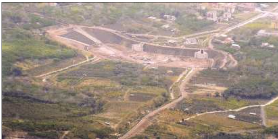
Figura 82. Vasca di Episcopo presso Sarno. Foto panoramica della piazza di deposito vista nella foto precedente (fonte: Quaderni del Presidio Territoriale – Commissario di Governo per l’Emergenza Idrogeologica in Campania).
