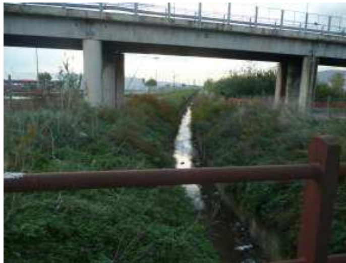
Figura 156. Lagno di Avella. Vista verso valle in prossimità del raccordo stradale della zona industriale. Come nella foto vista precedentemente la sezione si mantiene regolare e si presenta pulita da sedimenti e vegetazione.
