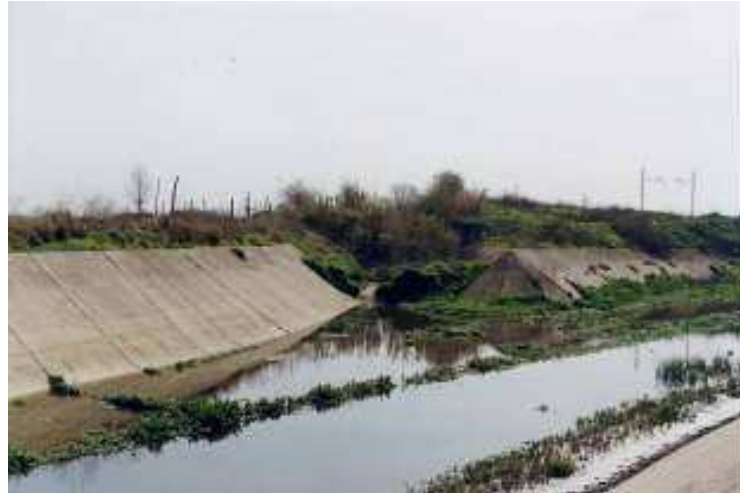
Figura 153. Lagno di Gaudio. Visto verso monte della confluenza con il canale dei Regi Lagni (Fonte AdBNO – 2001).
