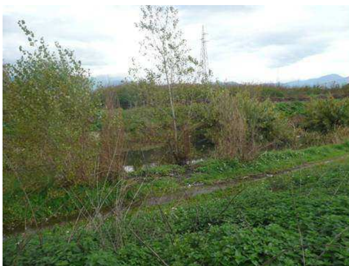
Figura 140. Lagno di Quindici. Vista verso valle in prossimità del Ponte delle Tavole. La sezione del Lagno di Quindici superato il Ponte delle Tavole si allarga, presenta forma composta e le sponde sono rivestite in calcestruzzo.
